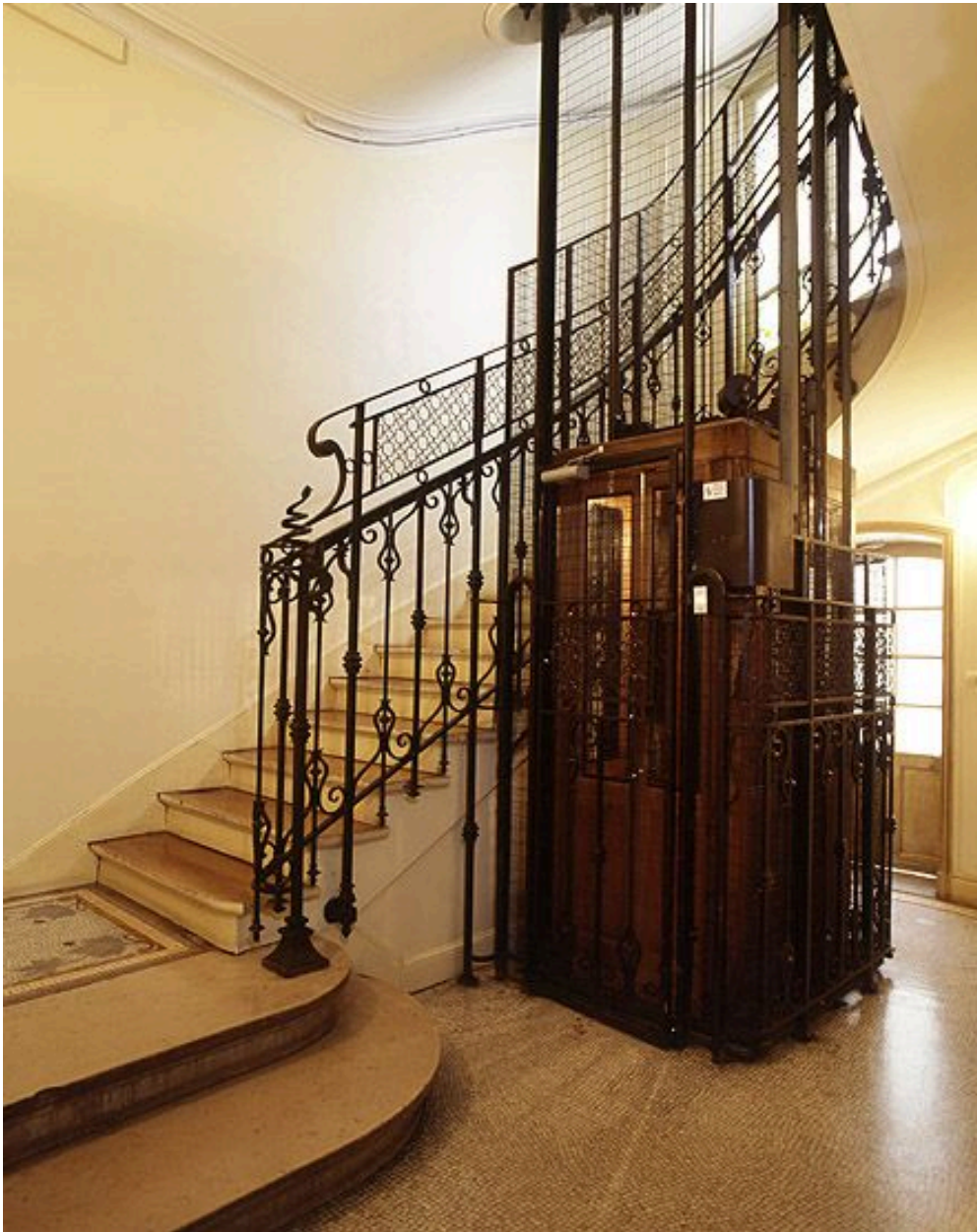
Vue d'ensemble au rez-de-chaussée du départ de la rampe d'escalier et de la cage d'ascenseur d'un immeuble, 8 place Robert Belvaux.
