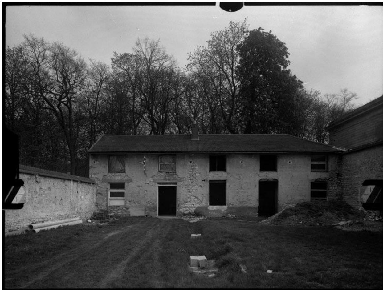
Pavillon en cours de restauration.
