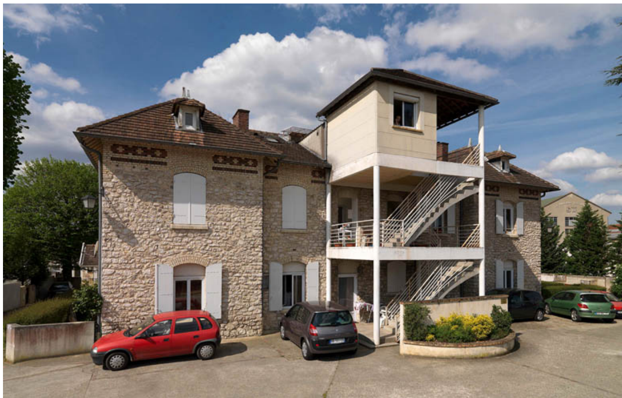
Le pavillon du directeur (1902) en meulière blanche et décor de briques polychromes, aujourd'hui reconverti en logements.
