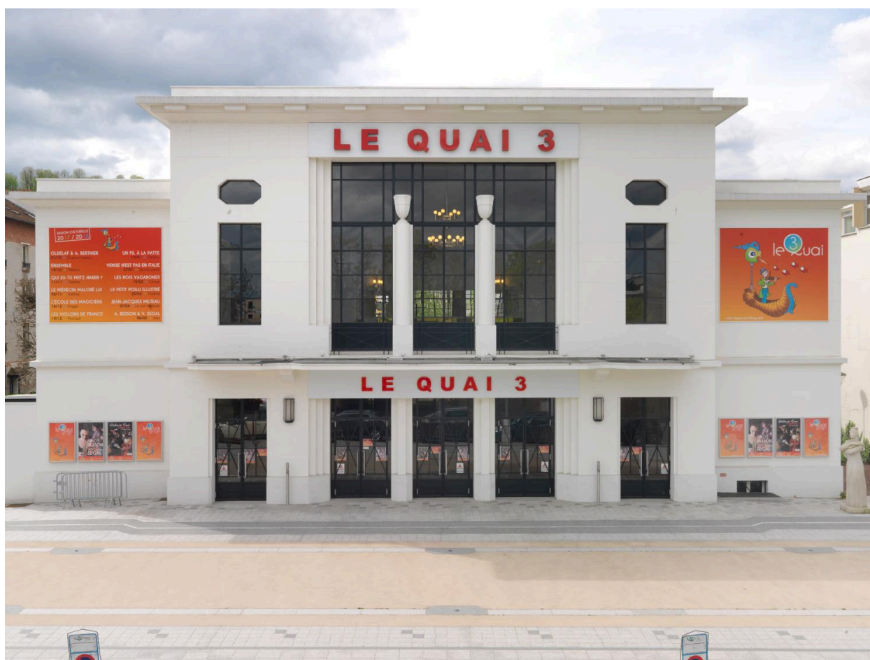
Vue générale du bâtiment
