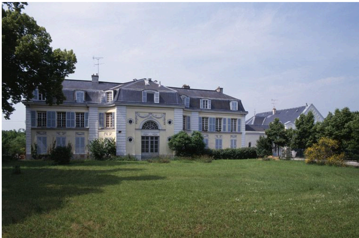
Vue d'ensemble, côté parc.
