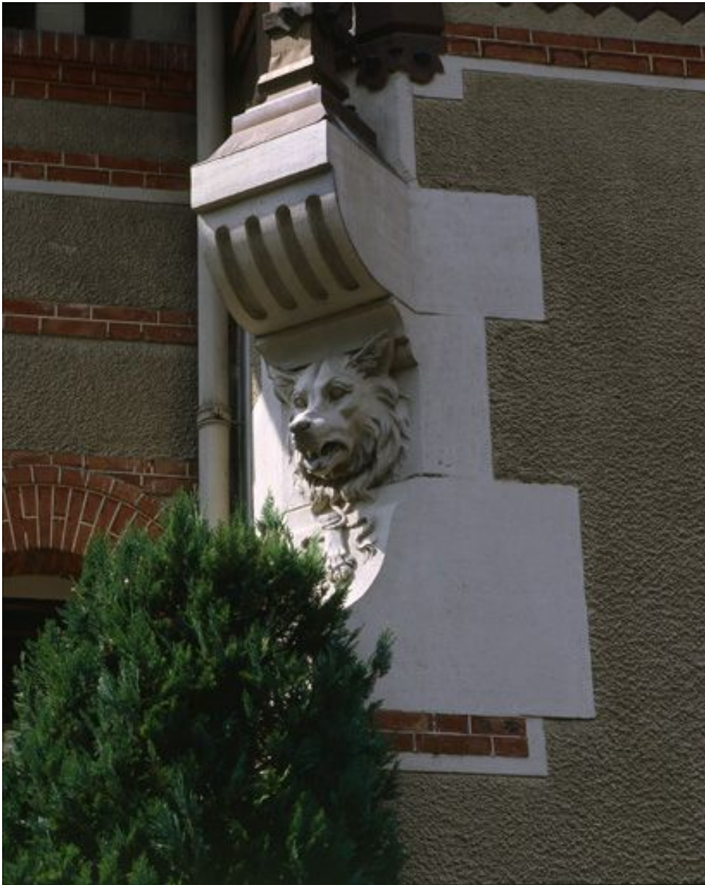
La Villa Kermina : détail du traitement de l'angle en pan coupé surmonté d'un corbeau supportant une colonette. Le pan coupé est orné d'une tête de chien en relief.
