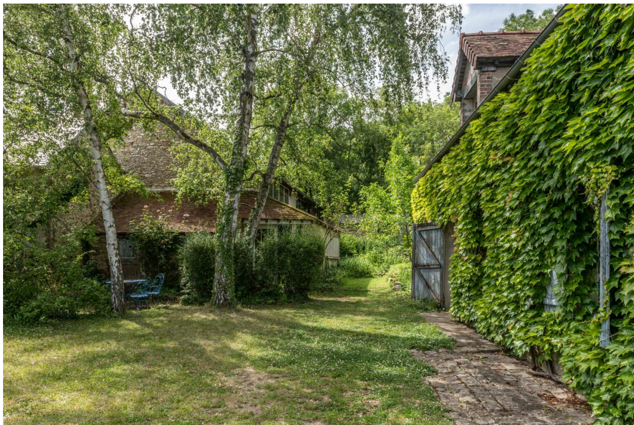
Vue du corps de logis et de l'atelier
