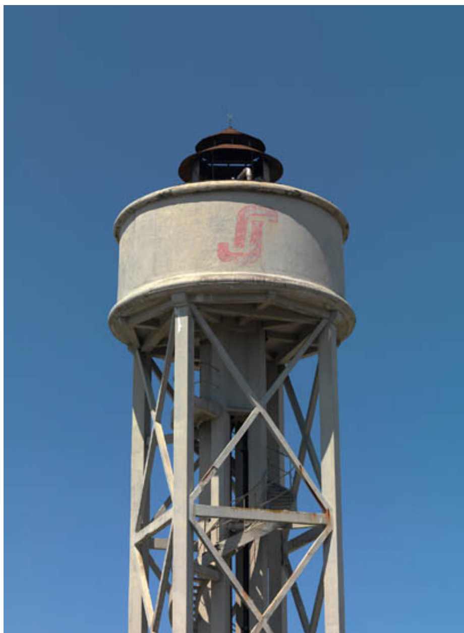
Chateau d'eau (1902). Ciment armé. Au sommet, la sirène installée en 1950 et le logo de la société Jeumont-Schneider.
