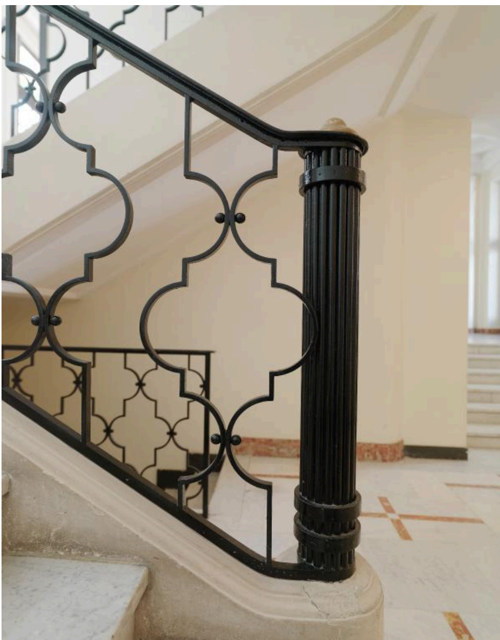
L'escalier intérieur, détail du départ de la rampe.
