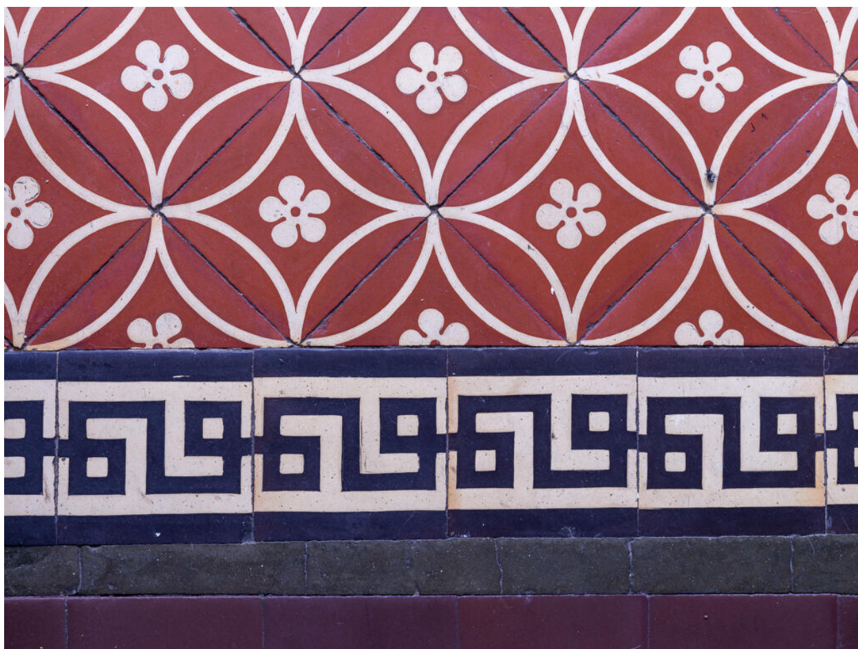
Vue de détail des carreaux de ciment composant le sol de la pièce sud-ouest.
