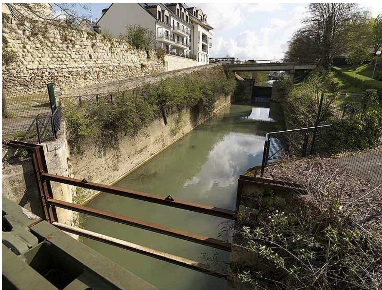
L'écluse, vue de l'ouest.
