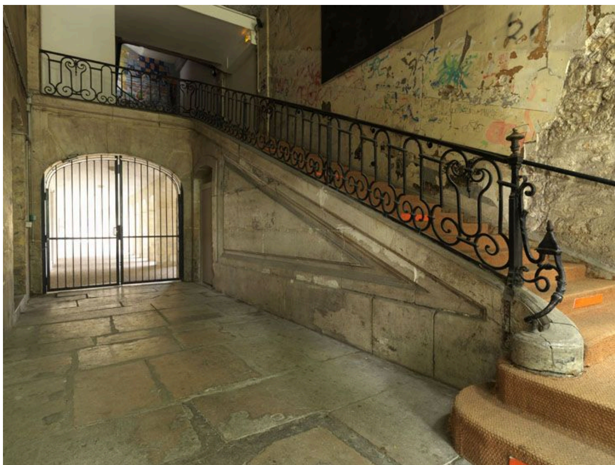
Vue d'ensemble de l'escalier.
