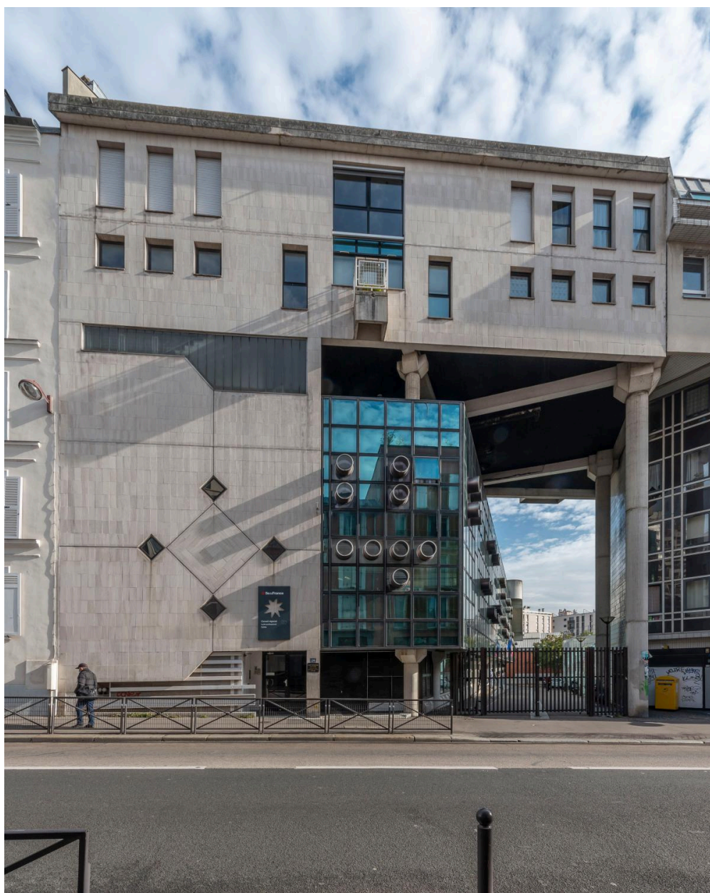
La façade du lycée sur la rue de Patay.
