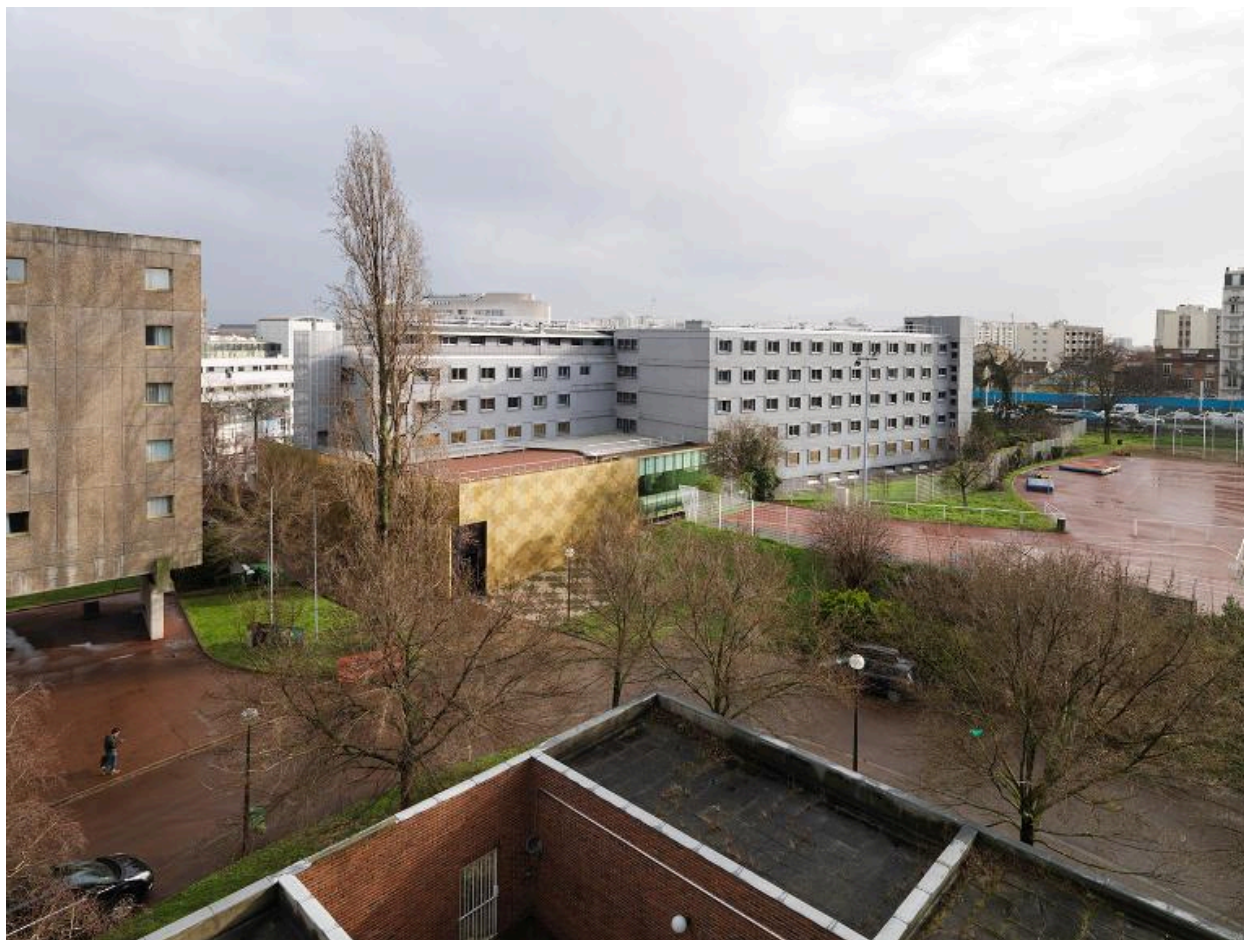
Vue d'ensemble prise des étages de la Maison de Norvège.
