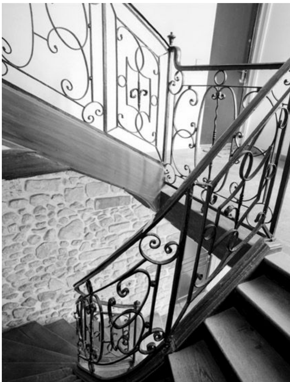
La rampe en fer forgé, vue du premier palier.
