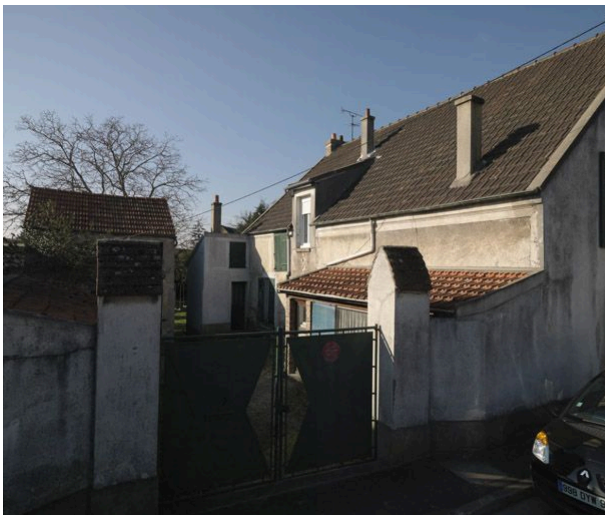
Vue d'ensemble de la ferme, 7 rue des Creuses.
