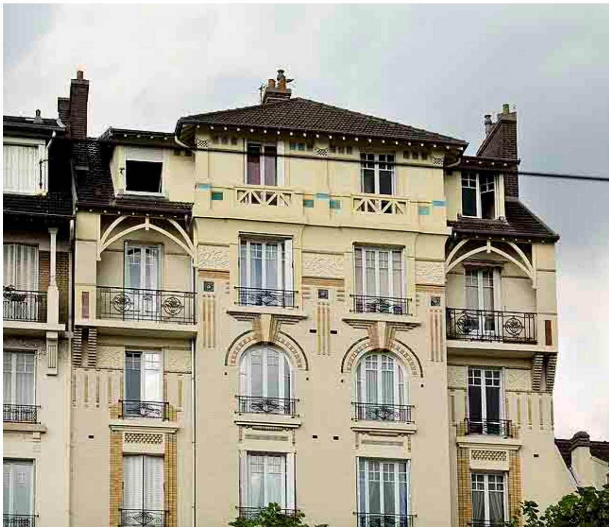
Détail de la partie supérieure de l'immeuble.
