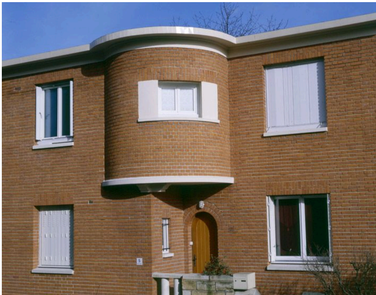
Détail architectural, rue Proudhon.
