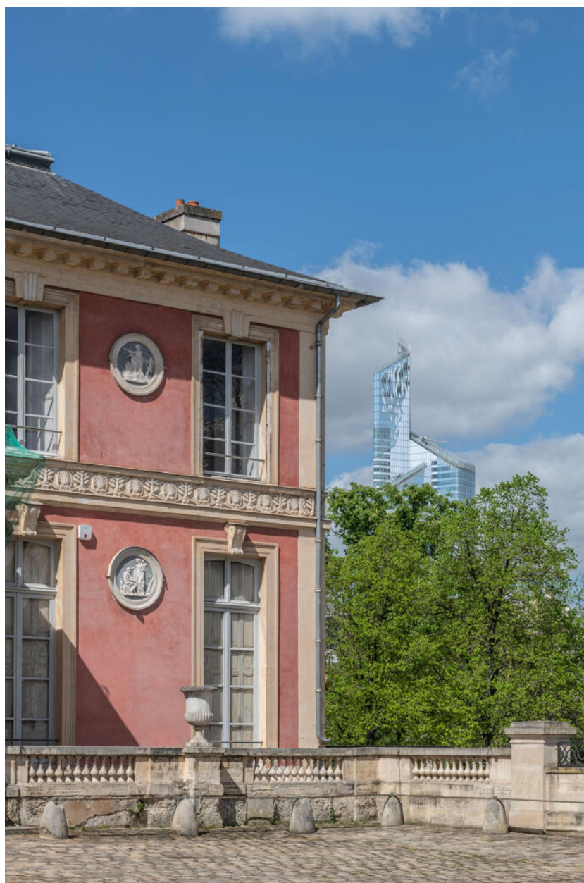
Façade sur rue, angle nord-est.
