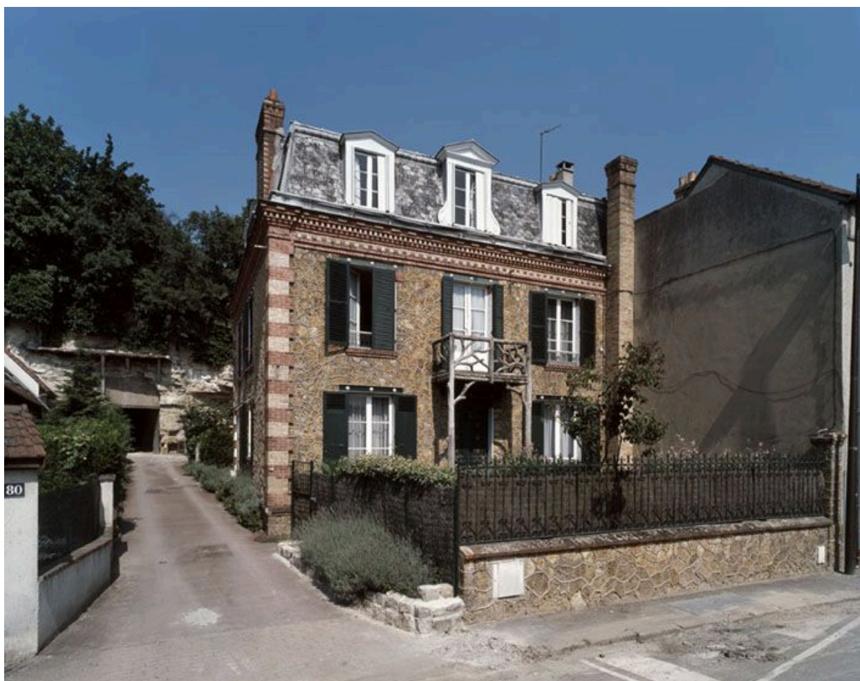
Façade principale avec un très beau balcon au décor rustique.
