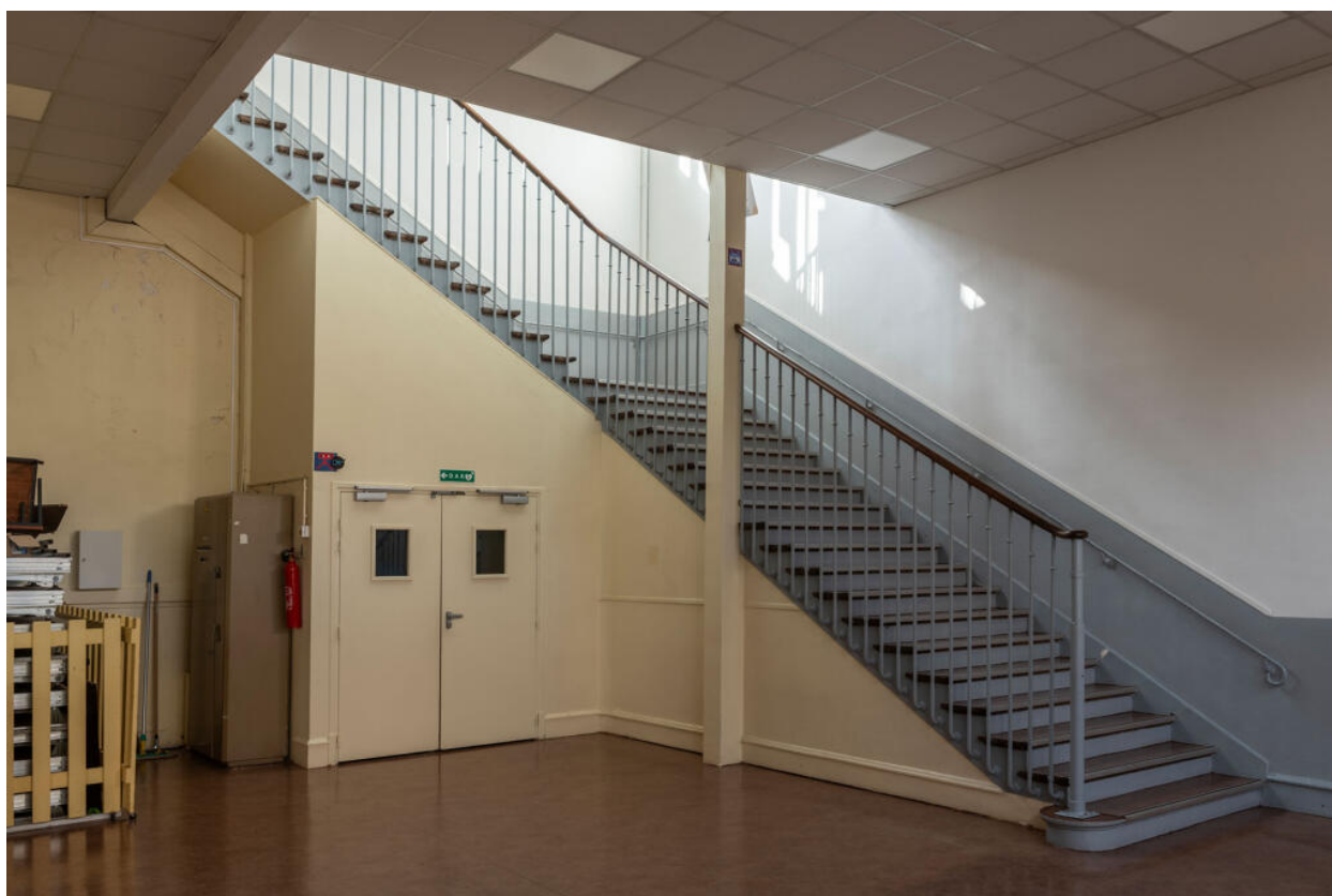
École des Coteaux, bâtiment de 1938, escalier principal
