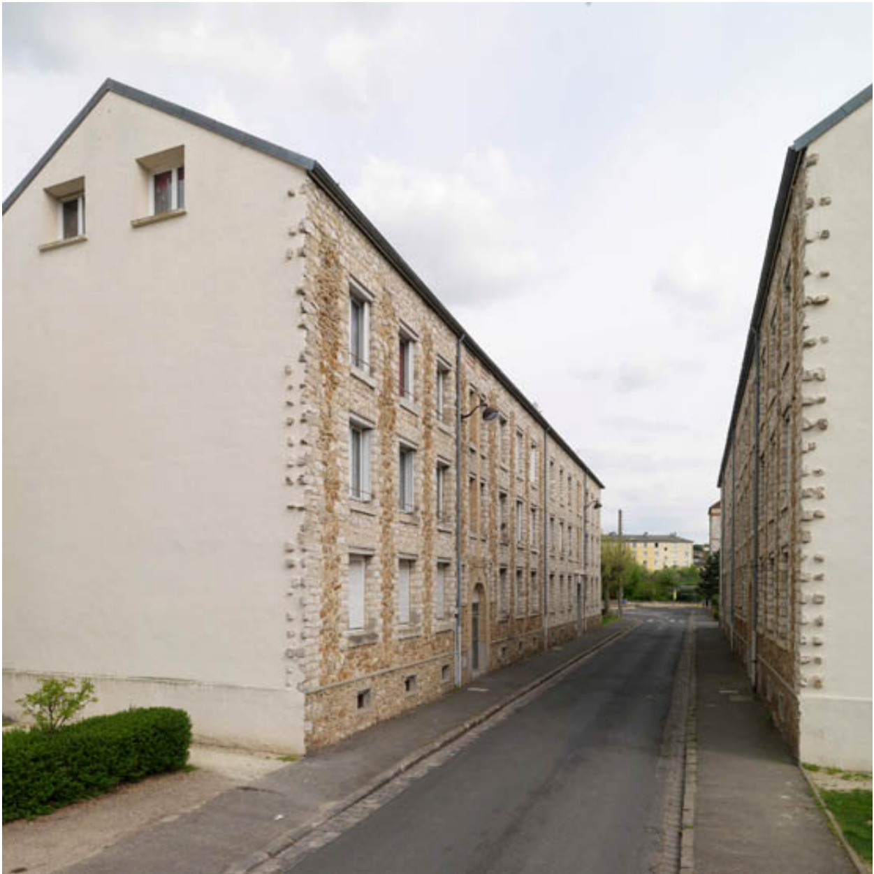
Ancienne rue du Pas-Rond, actuelle rue de la Libération. Immeuble en meulière blanche et brique claire construit en 1903
