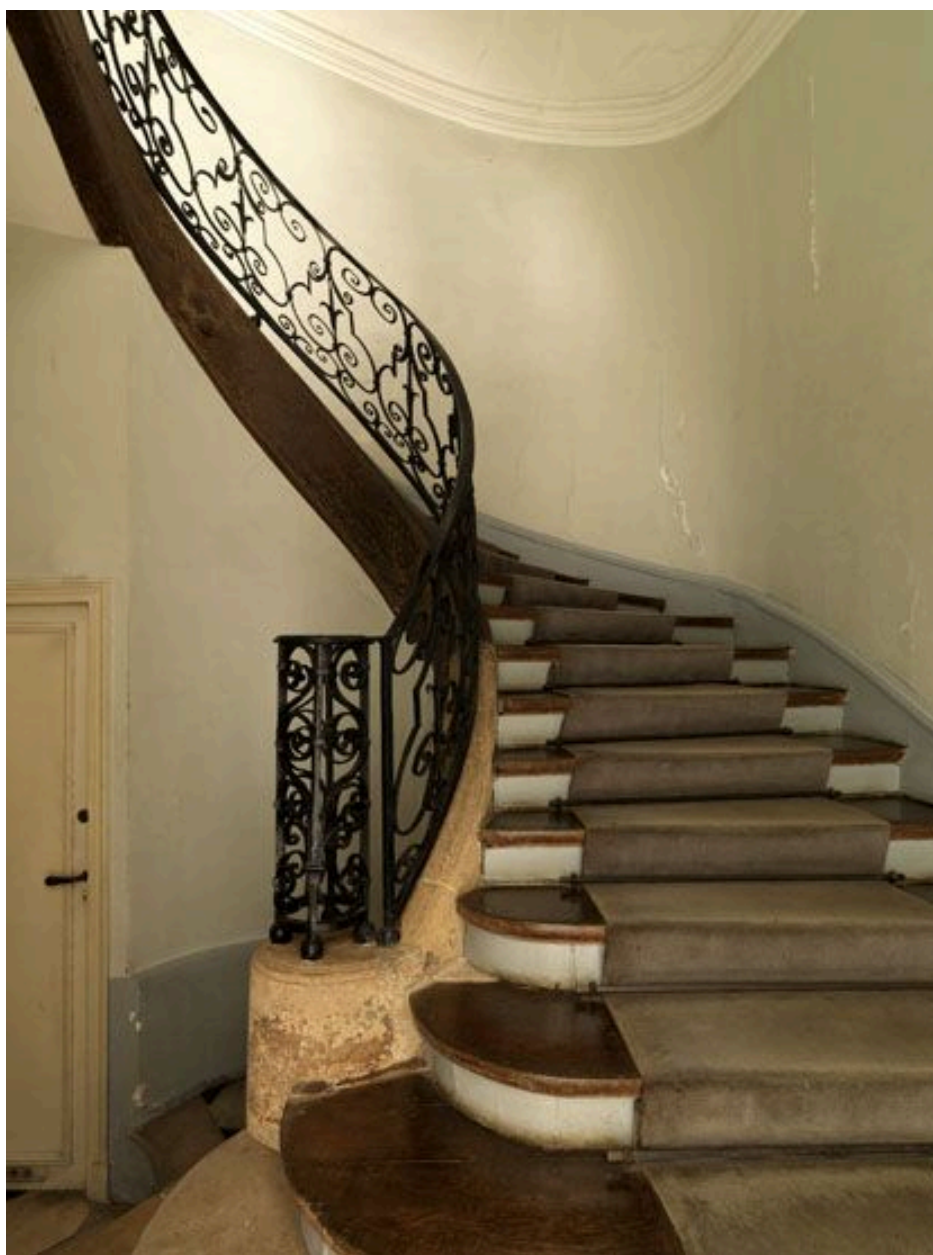
Le départ de l'escalier.
