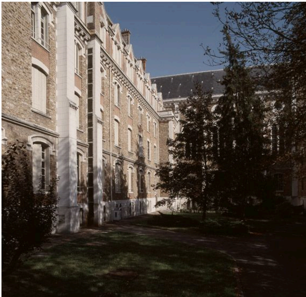
Le bâtiment de la communauté perpendiculaire à la chapelle.
