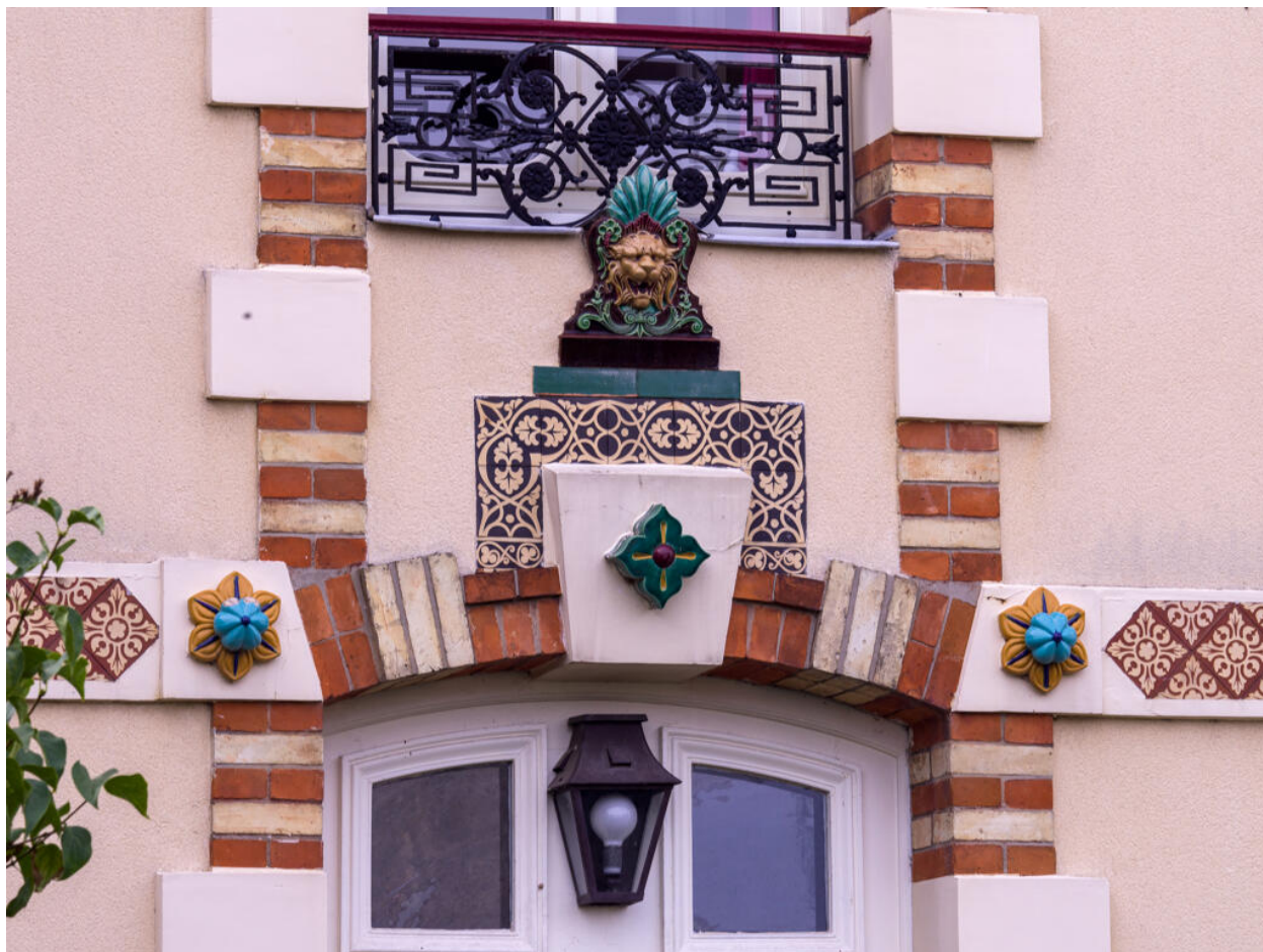
Vue de la façade nord, détail du linteau de la porte d'entrée.
