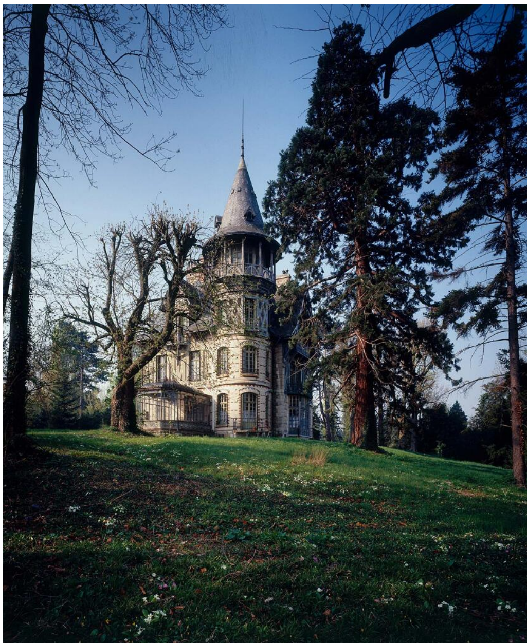
Vue d'ensemble de la tour d'angle, façade nord.
