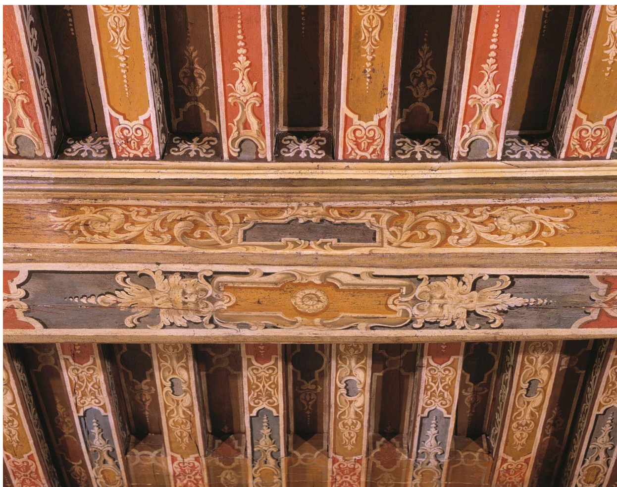
Détail du motif ornant la poutre transversale du plafond.
