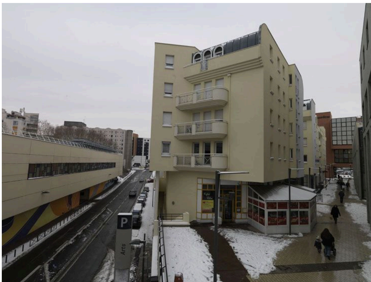
Elévation de la patinoire donnant sur la rue de la Préfecture.
