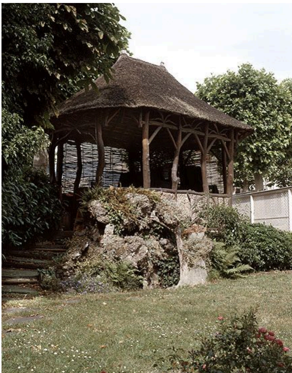
Maison, 58 avenue du Général de Gaulle. Kiosque en bois écorcé et ébranché et chaume dans le goût rustique, réalisé par la maison Martin, se trouvant dans le jardin.
