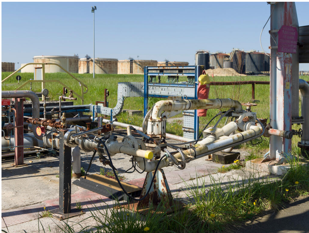
Zone de chargement GPL (Unité 550). Quai de chargement GPL. Bras de chargement GPL.
