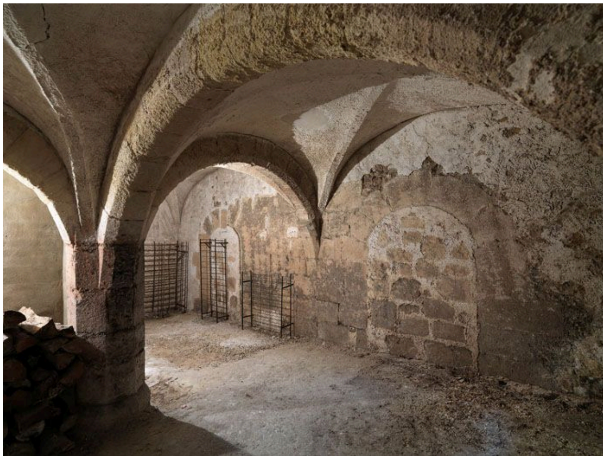
Vue intérieure : la partie ouest de la cave.
