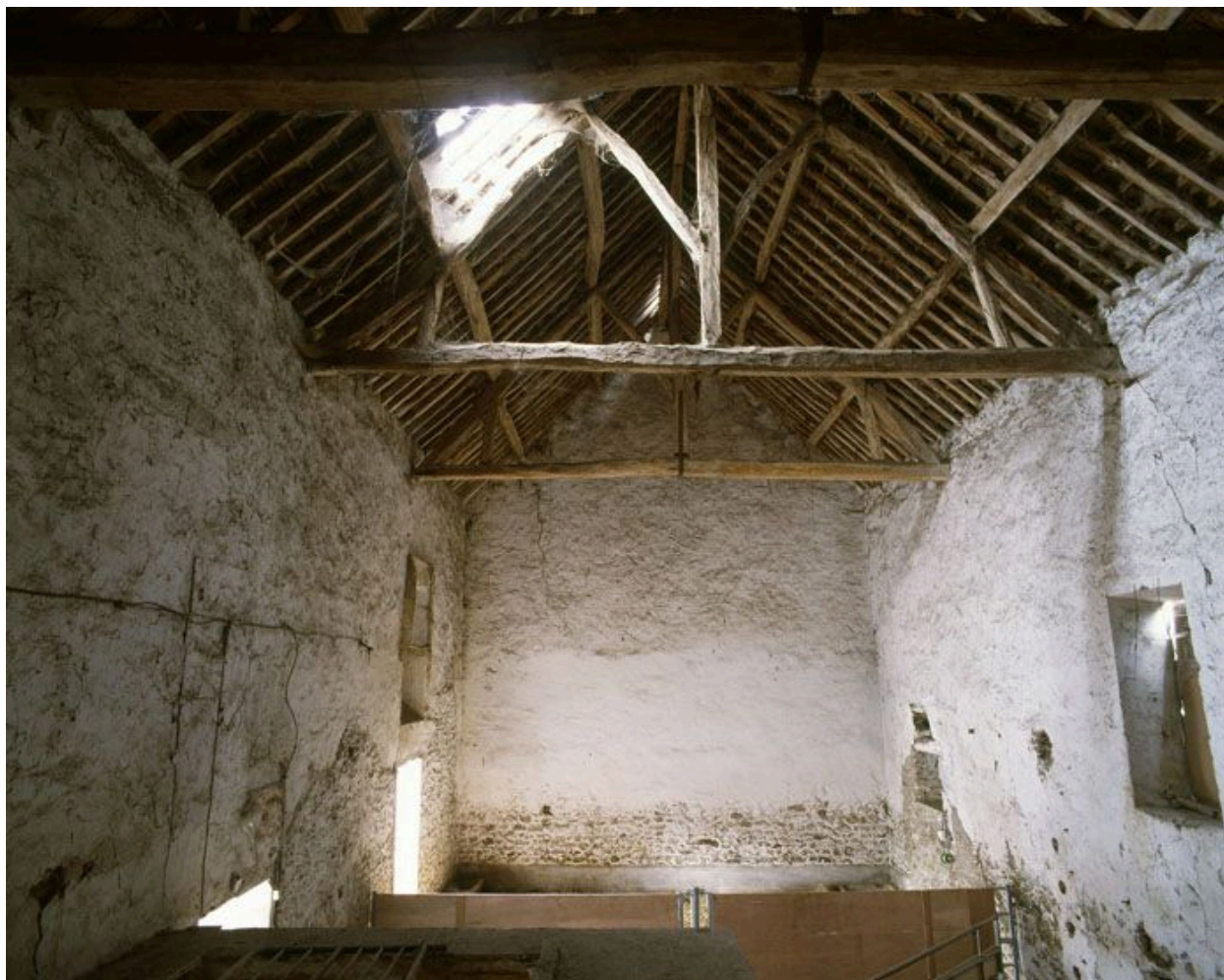
Vue intérieure du bâtiment se trouvant à côté du corps d'entrée.
