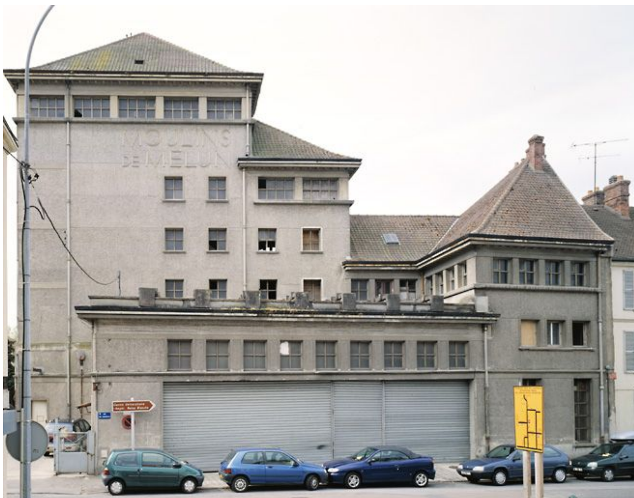
Elévation nord : façade de la minoterie, sur la rue du Château.
