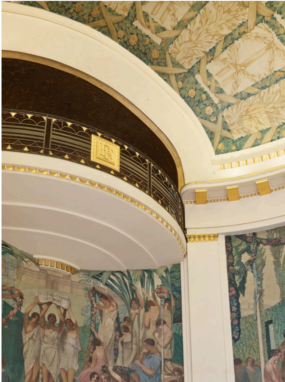
Balcon, garde-corps, voussure de l'alcôve
