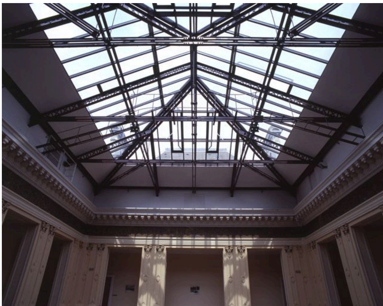
Détail de la corniche et de la charpente métallique supportant la verrière.
