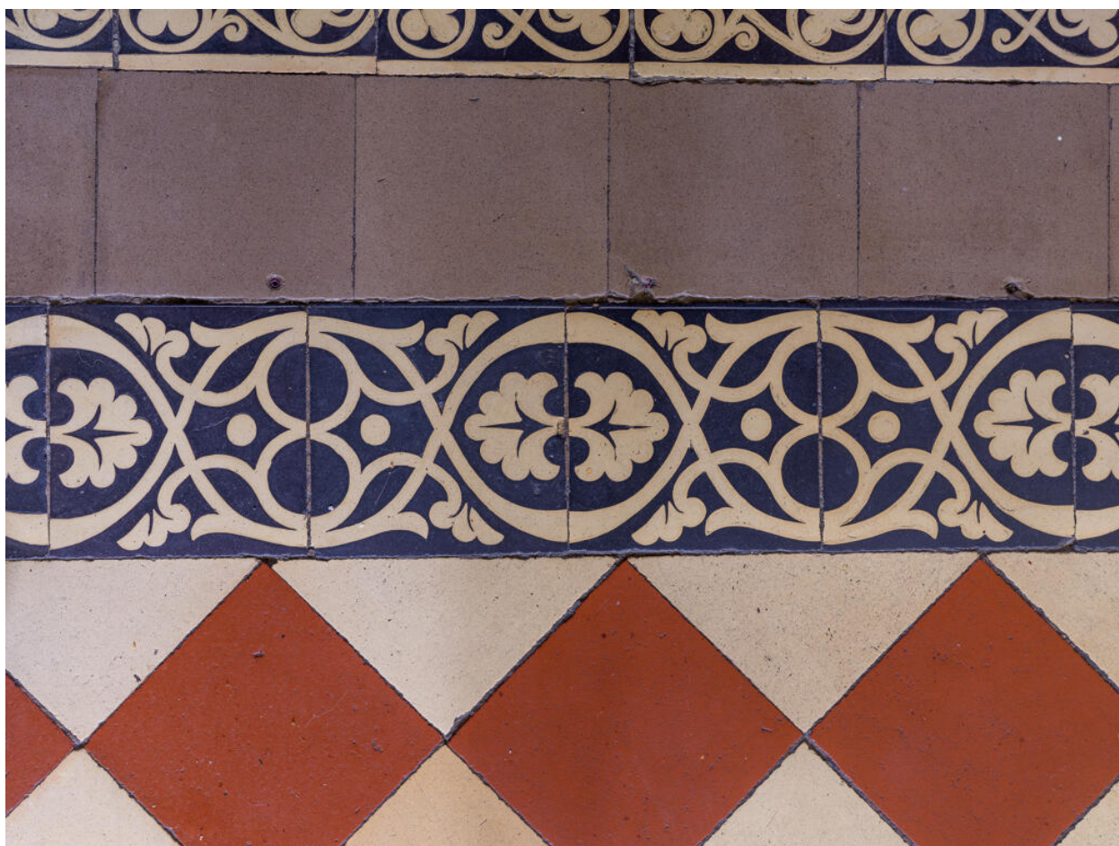
Vue des carreaux de céramique composant le sol de la cage d'escalier
