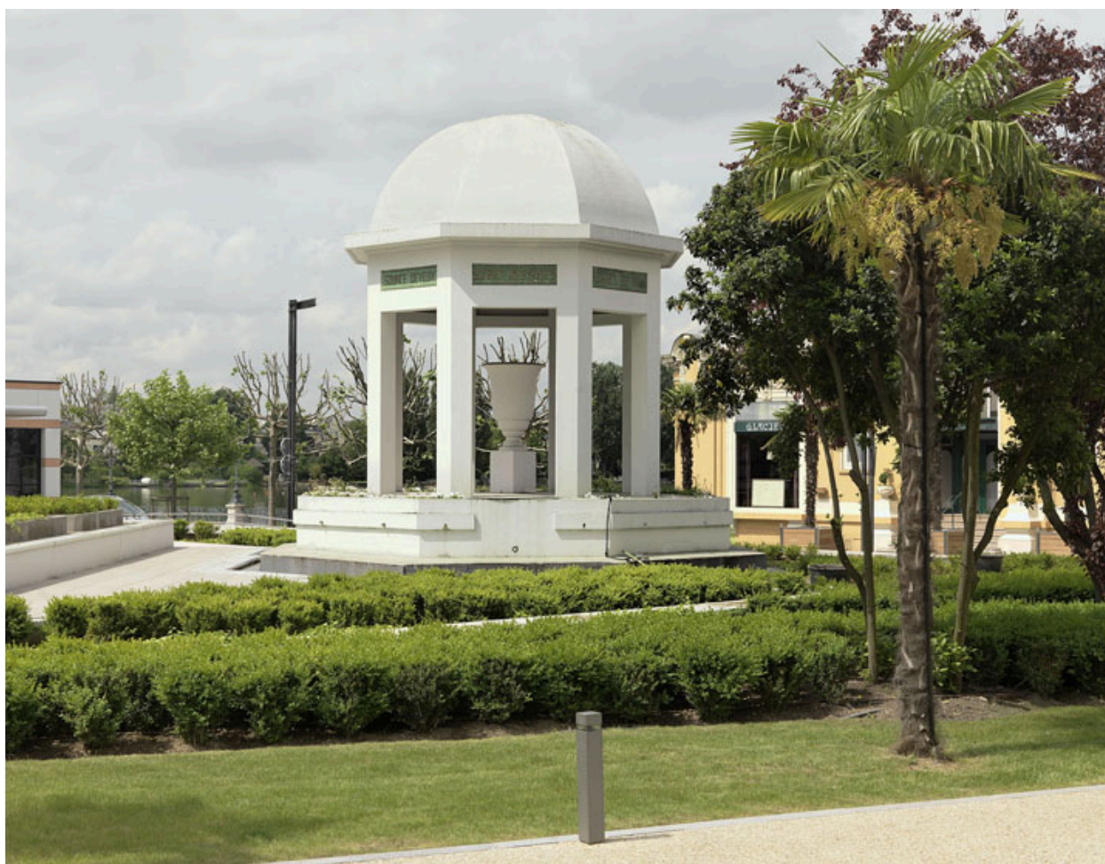
Vue d'ensemble du pavillon des sources.
