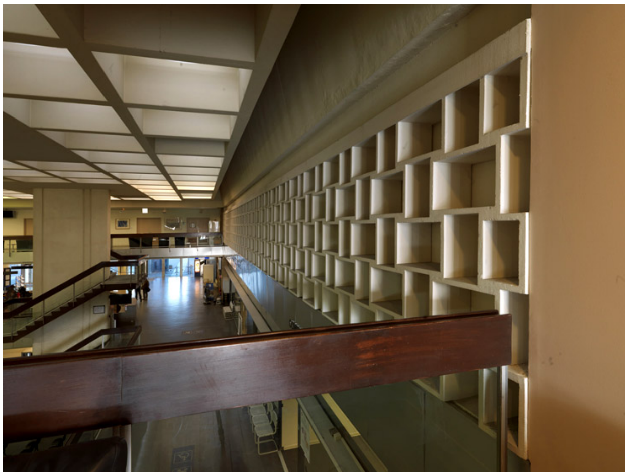
Les claustras de béton surplombant le hall d'accueil.
