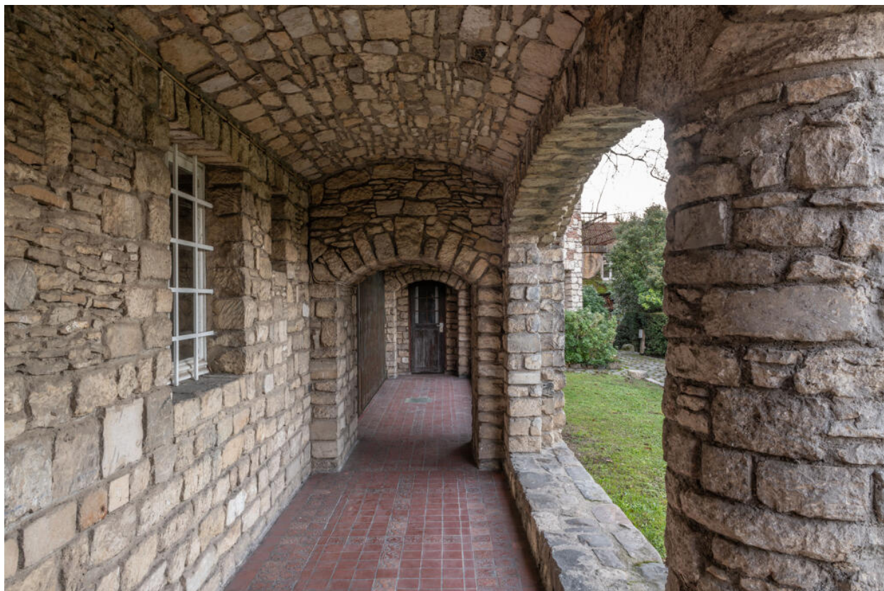
Villa des Tourneroches, galerie couverte au rez-de-chaussée de la façade orientale
