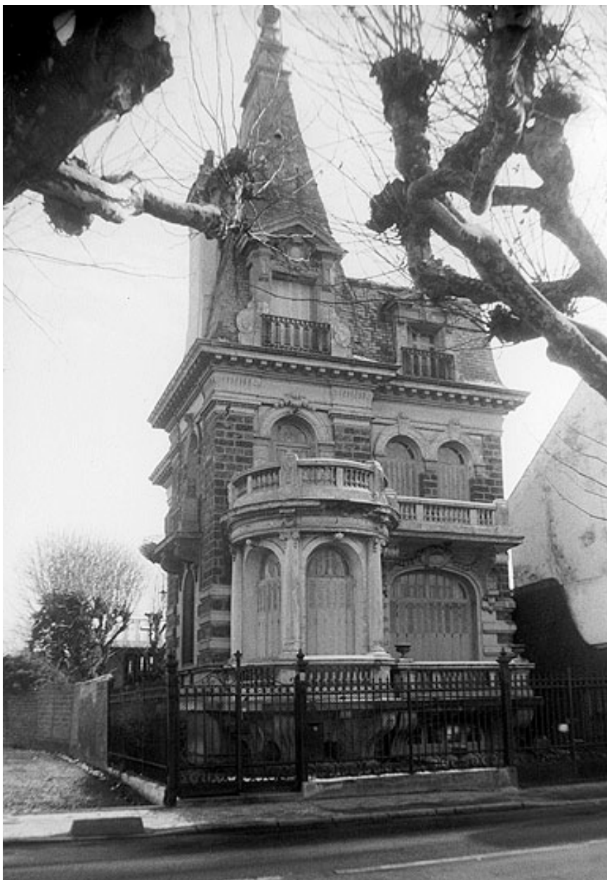
Vue d'ensemble de la maison prise lors de la campagne de pré-inventaire en 1985, aujourd'hui détruite.
