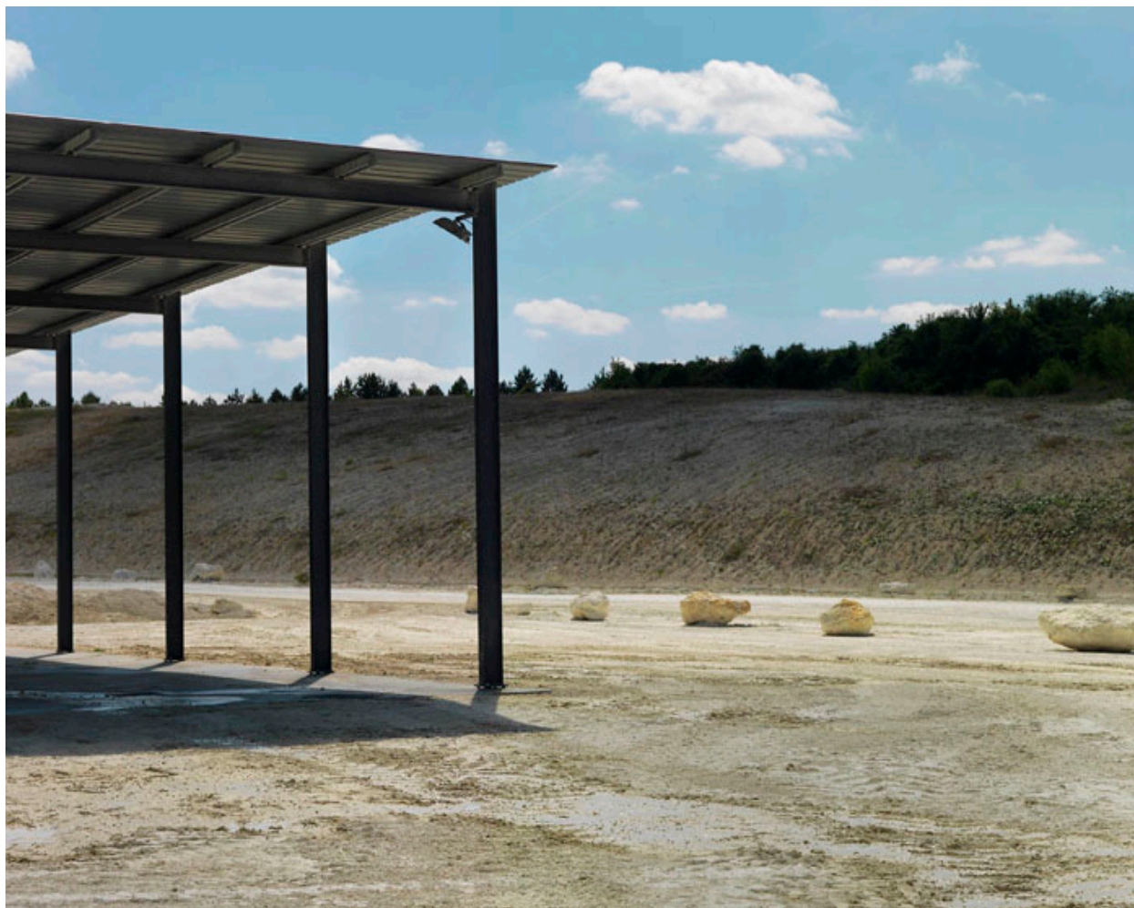
Ancienne centrale de malaxage.
