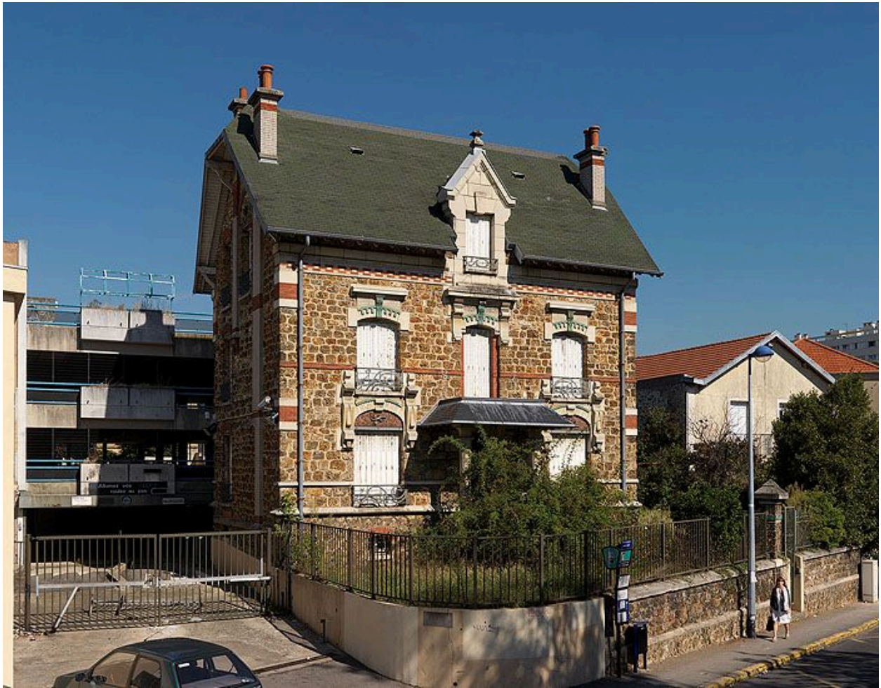
92, Fontenay-aux-Roses, maison, 4 avenue du Général-Leclerc. Façade antérieure meulière et brique.
