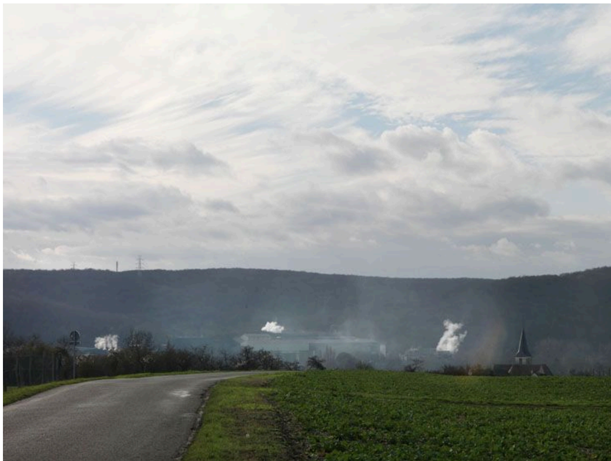
Bennecourt : route vers Gommecourt et vue sur Bonnières-sur-Seine.
