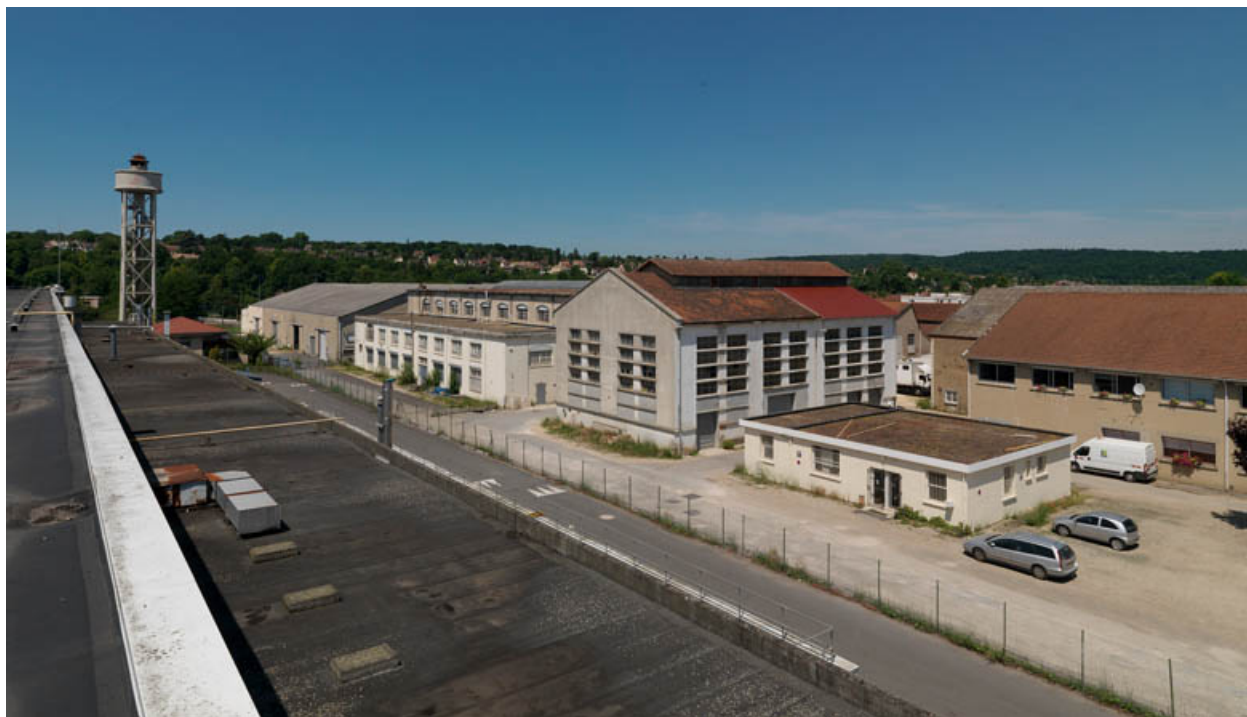
Vue sur le chateau d'eau en ciment armé (1902) depuis le toits des dépôts (années 1970).
