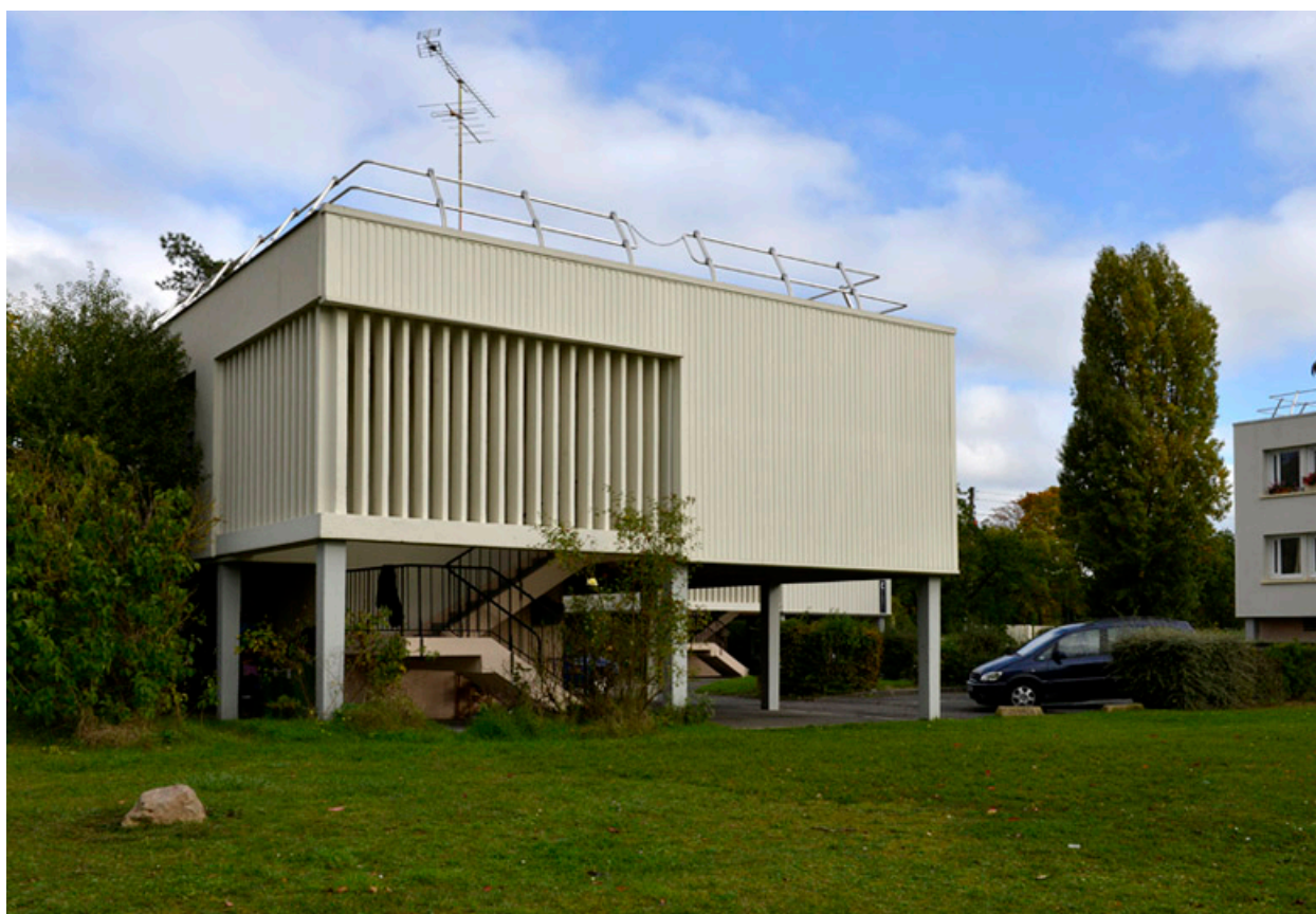
Vue de la façade arrière d'une maison individuelle.
