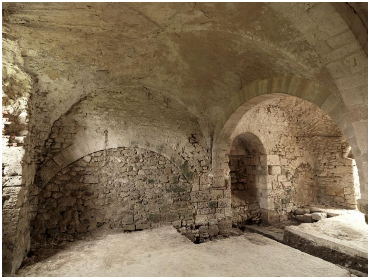
Vue sur le mur nord de la salle 4 de la grange des Beauvais.
