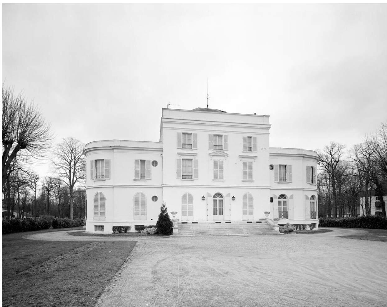
Façade vers la rue.
