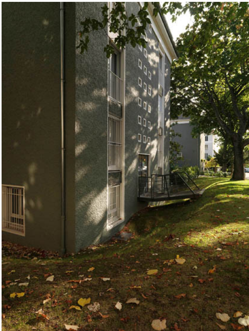
Vue du pignon de l'aile ouest.
