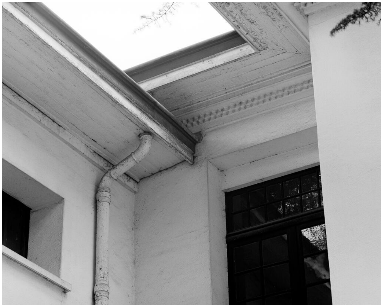
Détail du raccordement des corniches des pavillons Est et Sud. On distingue nettement les deux périodes de construction. Maison de maître dite le Moulin Fidel
