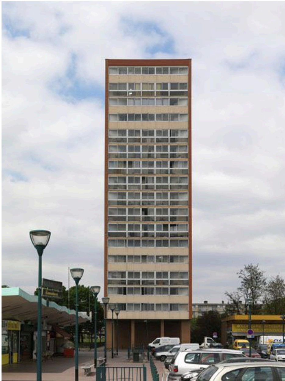
Pignon réhabilité avec les loggias fermées de la barre Q.
